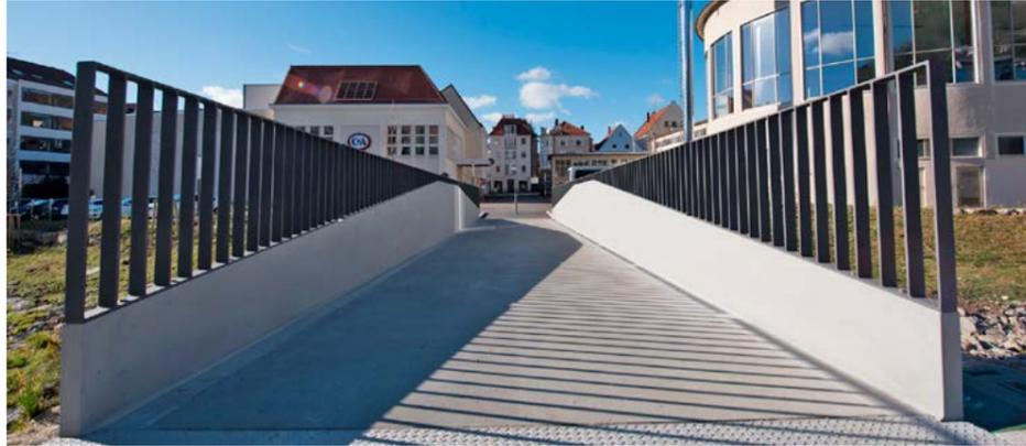
Abbildung 9: Erste Fuß- und Radwegbrücke aus Carbonbeton in Albstadt-Ebingen.
